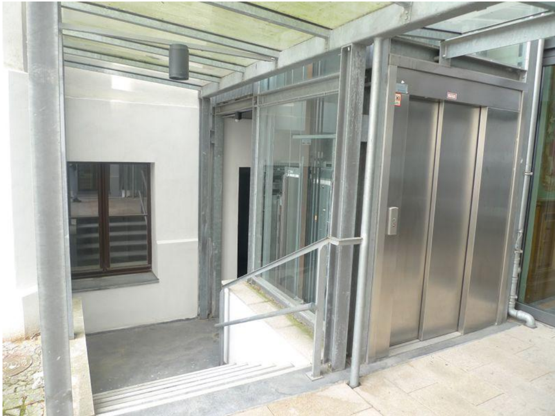
Praxiseingang mit Aufzug
