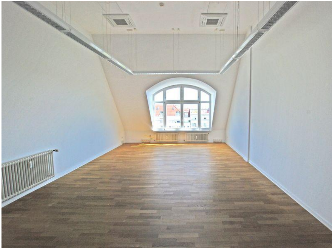
Bodenbelag nach Renovierung
