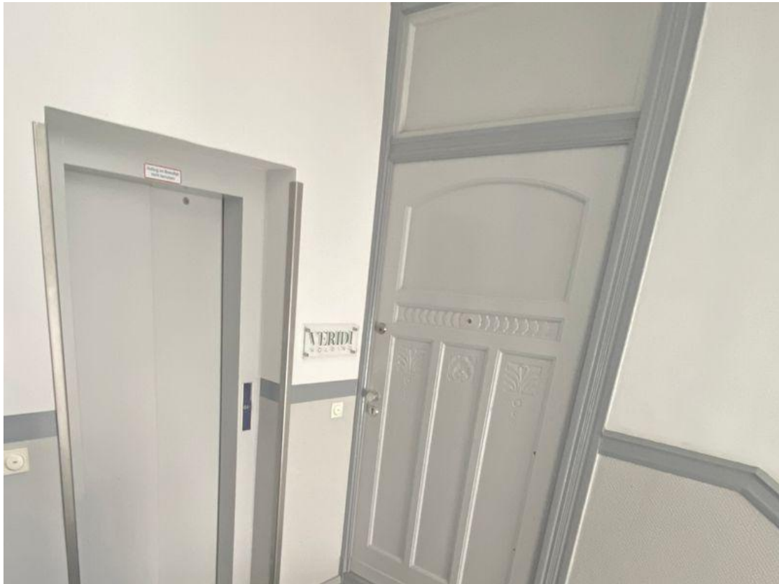
Aufzugstür und Etageingang
